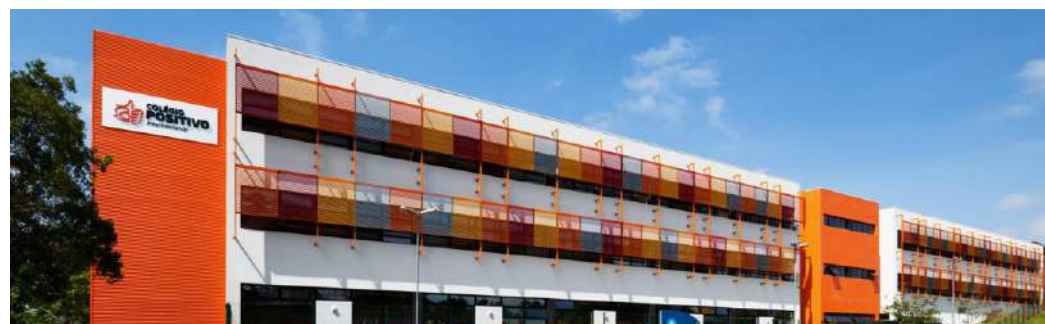
Utilização de brises para controlar a incidência solar.
